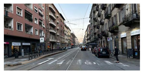
Fig. 24/ Torino, Quartiere San Donato, Via Luigi Cibrario. Immagine di una sezione stradale, contesto 1, dove è possibile rilevare la banchina per la fermata del trasporto pubblico; la corsia preferenziale per il trasporto pubblico; l'area per la sosta lungo la strada solo dove non è presente la fermata dei mezzi pubblici; il marciapiede pedonale da ambo i lati; l'attraversamento pedonale garantito dalle strisce pedonali a pavimento. (Foto dell'autrice, novembre 2024).
