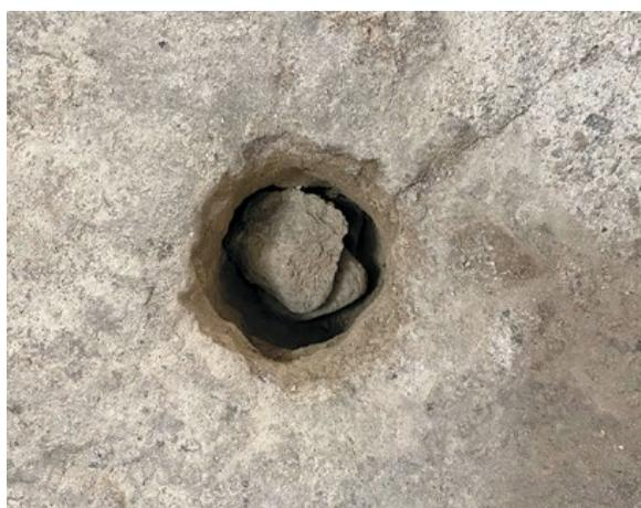
*Figure 44a-b.* Area absidale, porzione pavimentale in battuto di malta di calce, dopo il restauro. Rinvenimento di impronte che possono riferirsi ad elementi ora mancanti (foto O. Sterlocchi).
