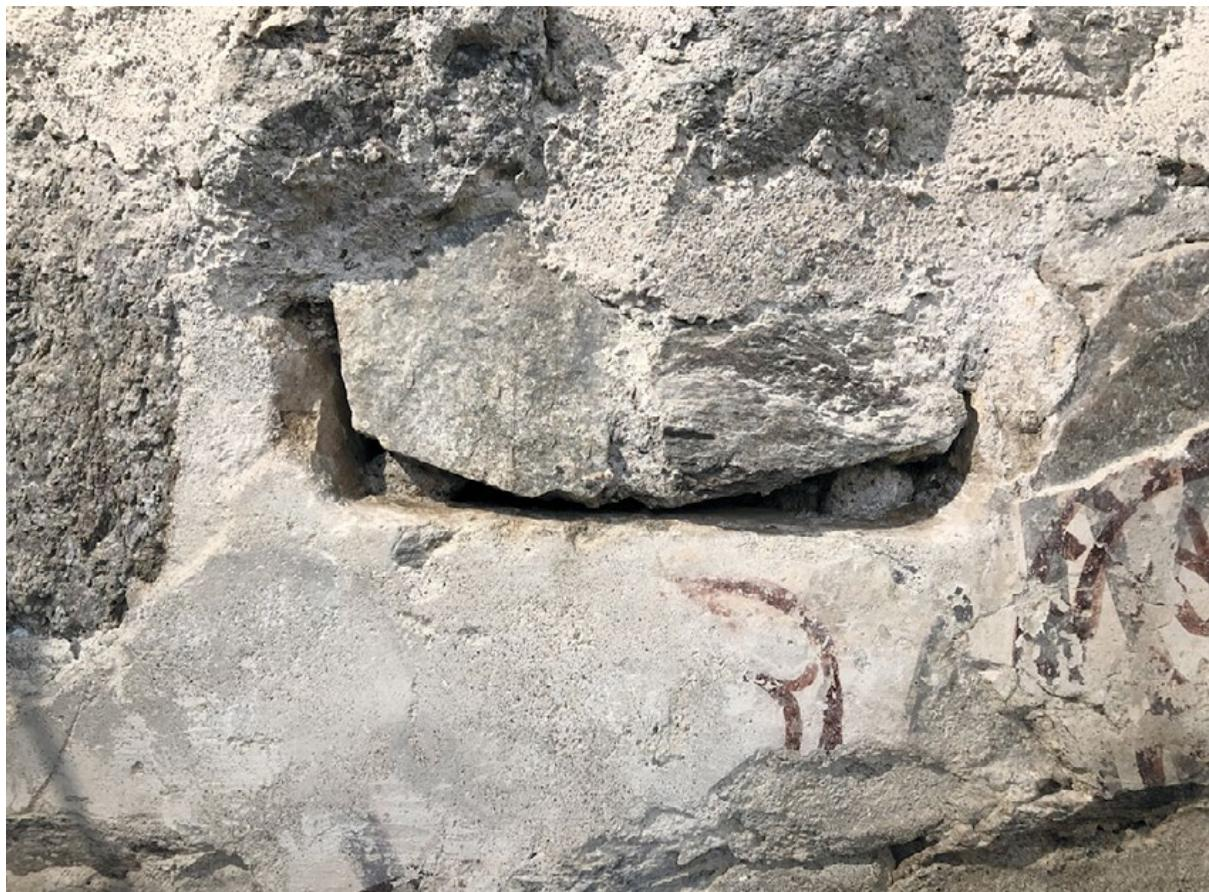
*Figura 31.* Aula, parete settentrionale. La rimozione di debordanti malte di ripristino ha permesso il rinvenimento della traccia di una piccola nicchia quadrata nella porzione muraria pertinente i lacerti pittorici del velario di prima fase e ad essi riferibile, probabilmente funzionale al deposito di piccoli oggetti di uso liturgico (foto S. Gianoli).
