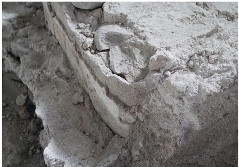
*Figura 41.* Altare, particolare del doppio strato d'intonaco che riveste il fulcro più antico, prima del restauro (foto O. Sterlocchi).
