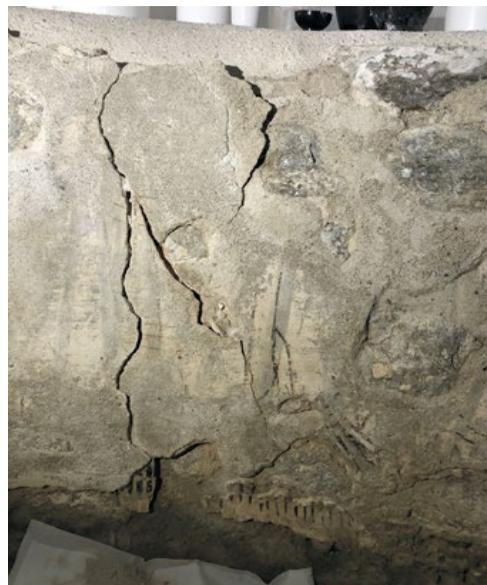
*Figura 21.* Emiciclo absidale, porzione sud-est, durante il restauro. La rimozione delle vecchie stuccature mostra in tutta evidenza l'entità del dissesto in corrispondenza delle profonde fratture della muratura e la precarietà degli intonaci circostanti, soggetti a nuovi processi di disgregazione e scagliatura per esposizione a valori ambientali ancora instabili (foto S. Gianoli).
