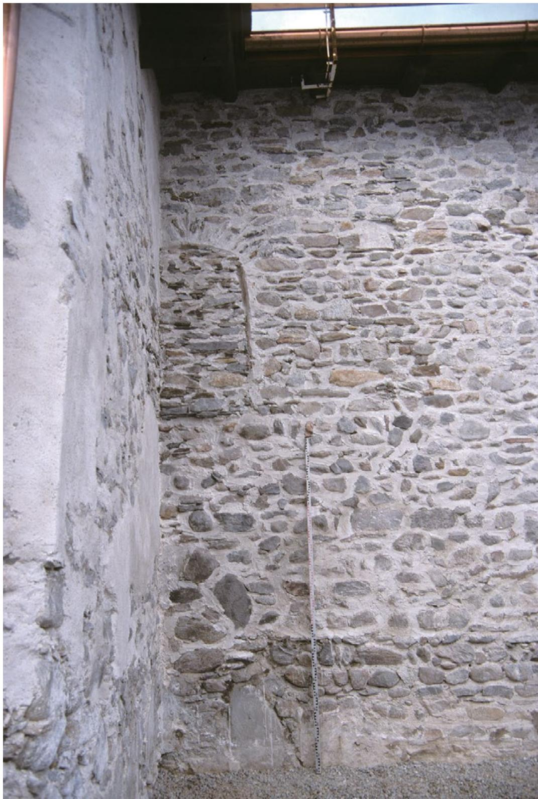
*Figura 12. Scavo 1999, muro perimetrale S, portalino di fase 2 successivamente tamponato (foto Archivio SABAP).*
