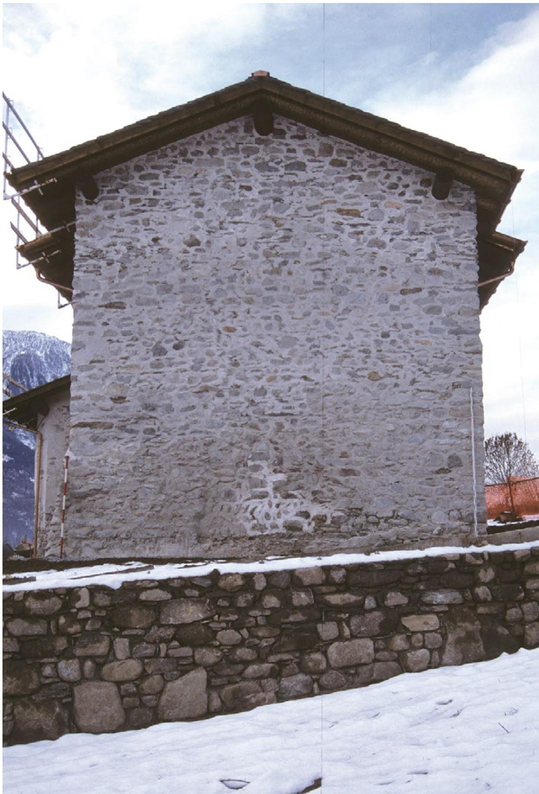
*Figura 31. Scavo 1999, prospetto E del coro, al centro si nota l'estradosso dell'abside dell'edificio medievale inglobato nel nuovo coro quadrangolare (foto Archivio SABAP).*
